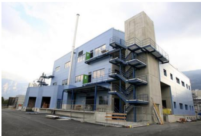
Bâtiment de production
