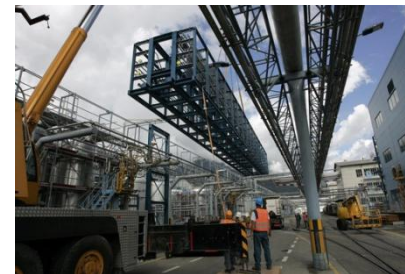
Rack de tuyauteries
